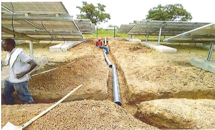
Figure 8 : Travaux de câblage d'un site solaire PV
