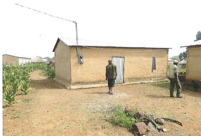
Figure 9 : Mode de branchement des clients abonnés.
