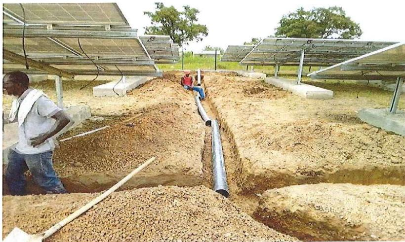
*Figure 8 : Travaux de câblage d'un site solaire PV*
