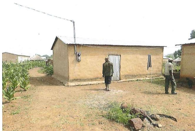
*Figure 9 : Mode de branchement des clients abonnés.*
